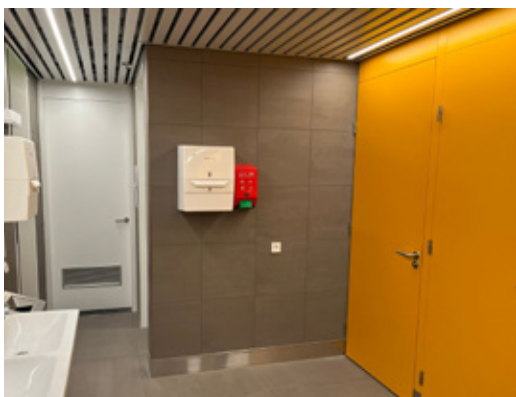
Opgeknapte rustruimte en toilet
